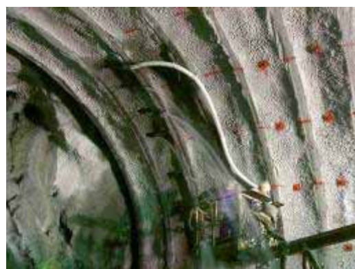
写真 - 2 前方探査を利用した湧水対策
