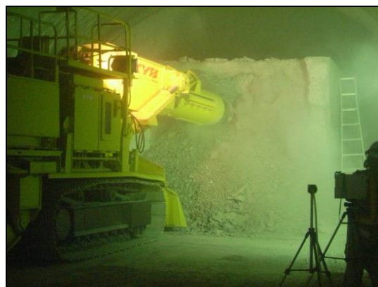
写真1 模擬岩盤の掘削状況
