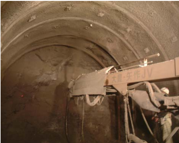
図1 高機能吹付けコンクリート吹付け状況
