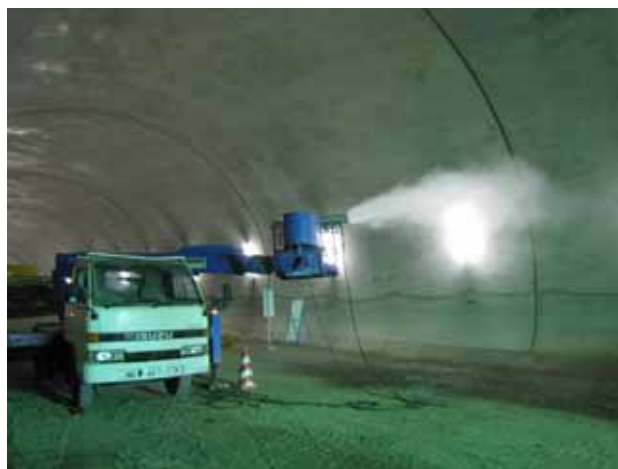
写真 噴霧養生装置運転状況
