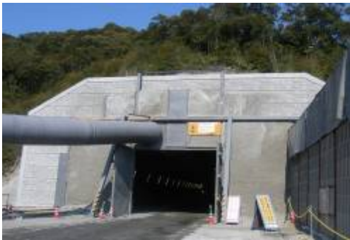
写真-1 坑口部設置状況 吸音パネル埋設 型吹付け防音扉
