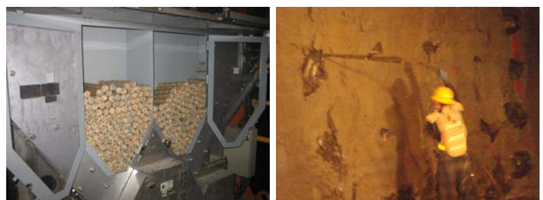
写真-2 爆薬遠隔装填システム装填機内部と装填状況
