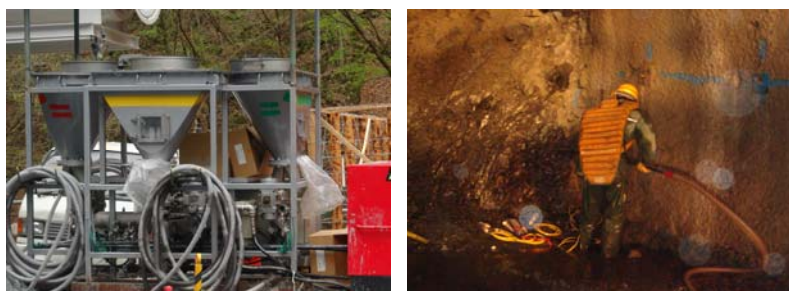
写真-1 粒状エマルジョン爆薬装填機械と装填状況
