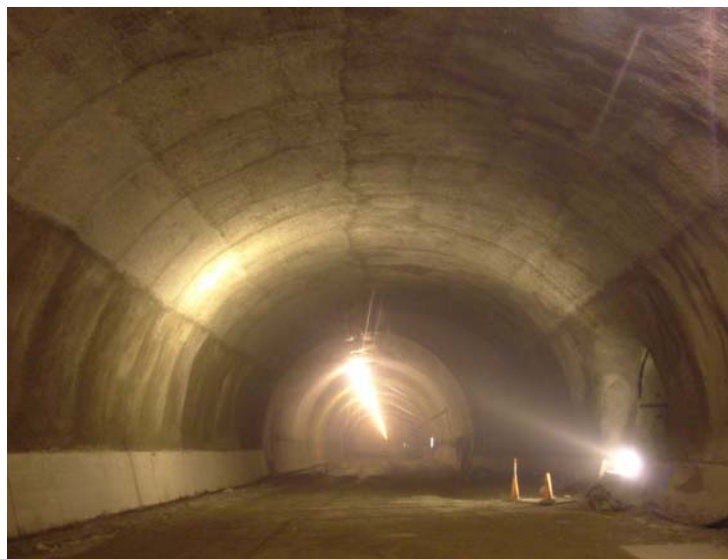
図6 吹付け覆工完了状況
