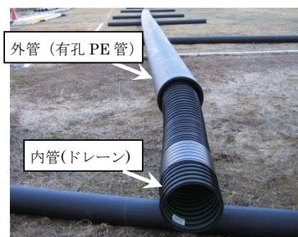
写真-2 二重管式ドレーン
