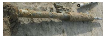
図-3 従-1 掘り出し後の状況
