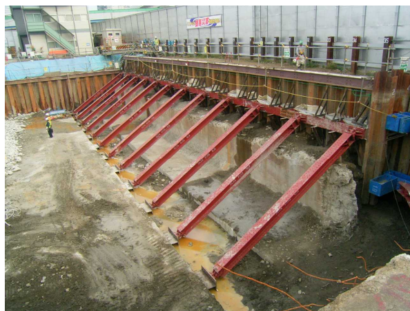
写真-1 斜梁設置完了
