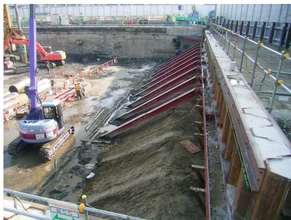
写真-2 押え盛土設置、斜梁撤去状況
