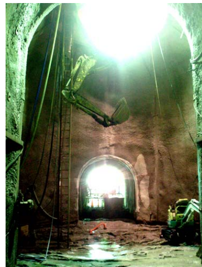
写真1 換気立坑深度200m坑底部(ボーリング横坑から深度200m予備ステージをのぞむ)
