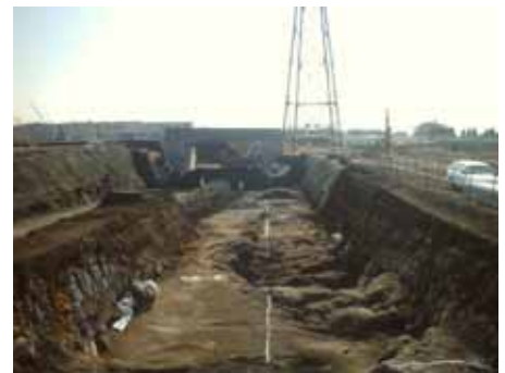
写真-1: 置換え掘削完了
