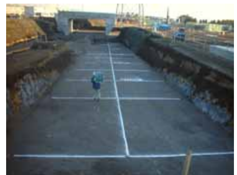
写真-2: 置換え盛土完了
