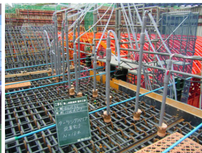
写真-2 クーリング状況
