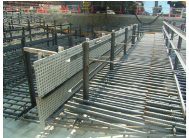
写真-1 埋設型枠設置状況(底版)
