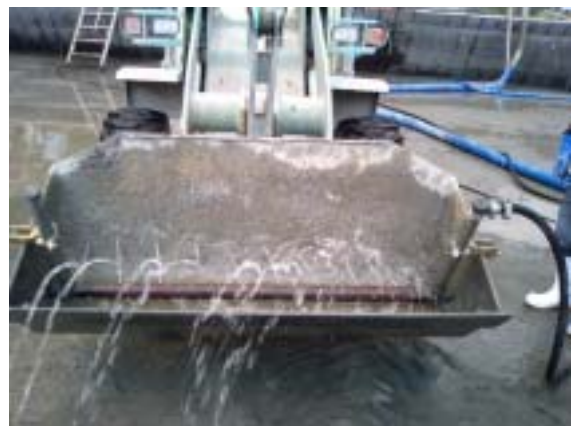
写真-5 グリーンカット洗浄設備
