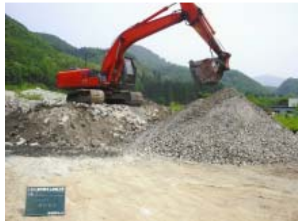
写真-4 コンクリート破砕状況
