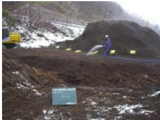
写真-2 土壌改良材施工状況
