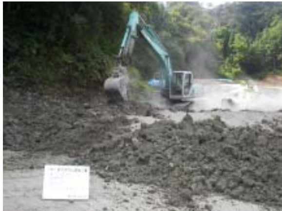
写真-3 脱水ケーキ改良状況
