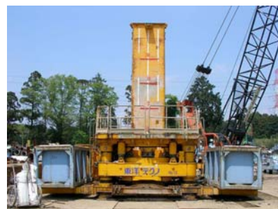
写真-1 施工試験の状況
