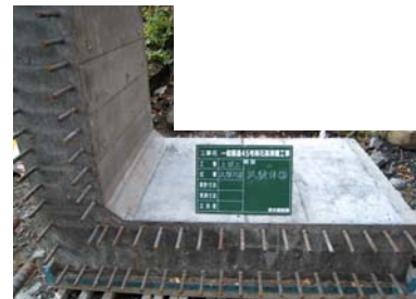
図5 脱型後の試験体
