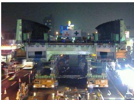
写真-2 移動多軸台車による一括架設
