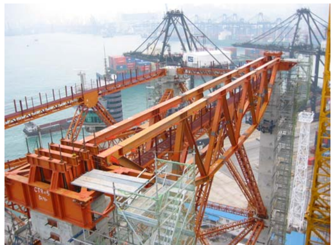
写真-3 横梁構築用トラス
