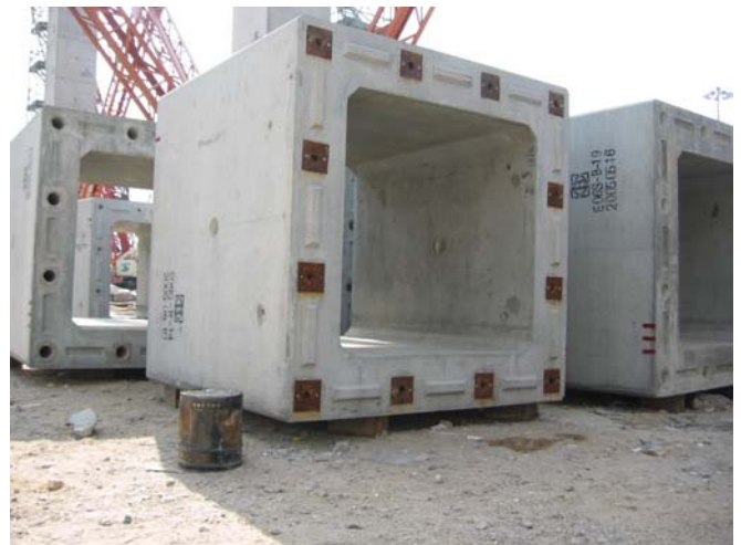
写真-2 プレキャストコンクリートセグメント
