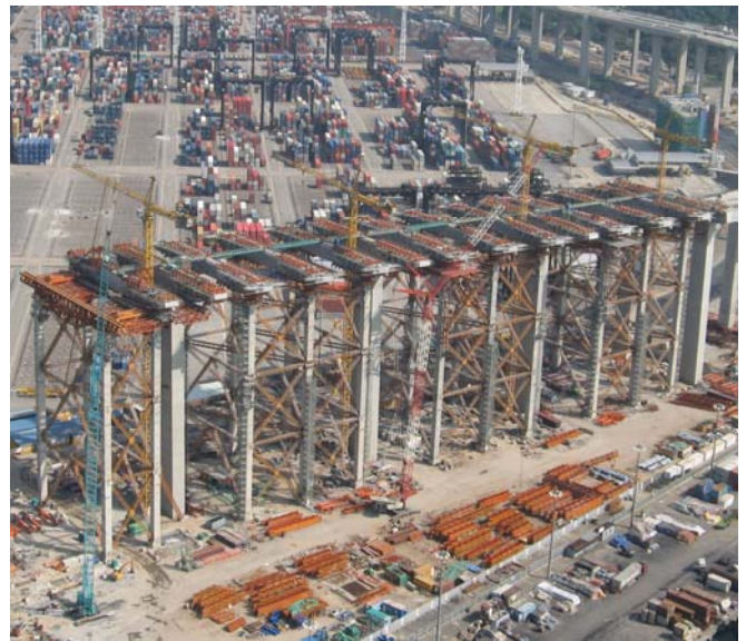
写真-1 側径間支保工施工
