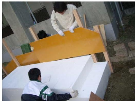
写真-3 EPSブロック部施工
