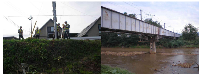
図-6 酢川橋梁でのレベル測量の様子
