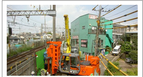
写真 - 1 下り線近接作業状況
