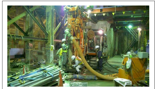
写真 - 2 立坑内施工状況
