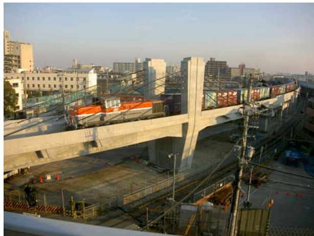
写真—1 ED橋完成
