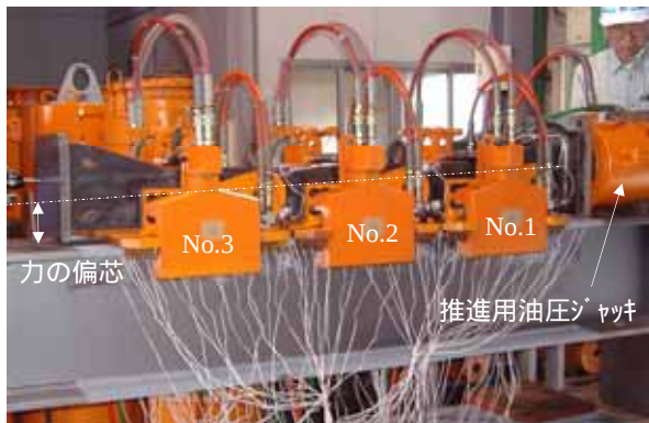
図-3 既存3連ジャッキによる検証試験
