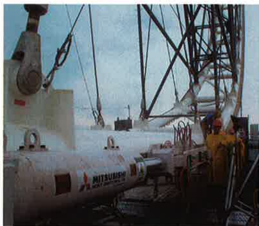
図-5 送出用大型推進ジャッキ
