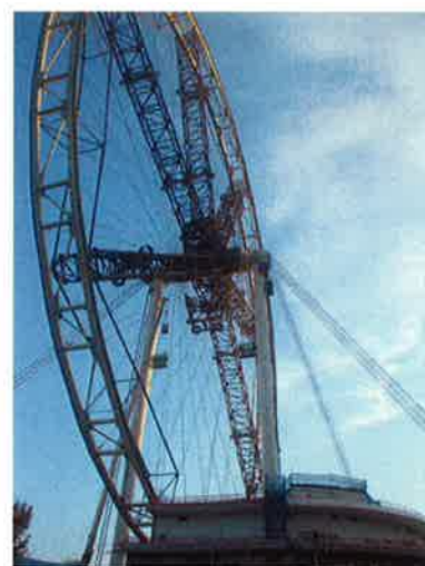
図-7 仮設ストラット解体
