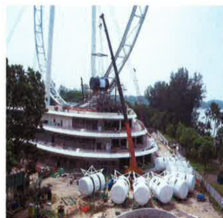
図-8 大型キャビンの架設
