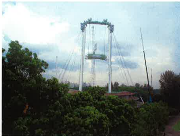
図-4 旋回軸吊り上げ架設状況
