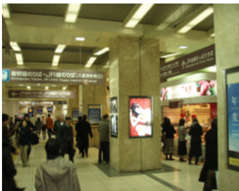
写真-1 耐震補強対象柱（東京駅）
