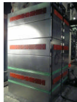
写真-4 2分割施工
