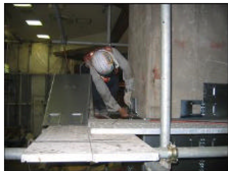
写真-2 組み立て状況
