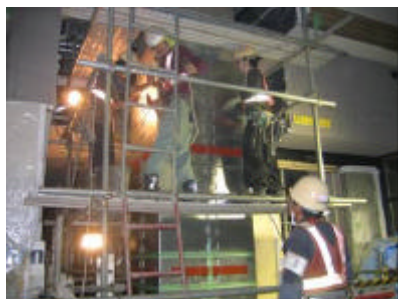
写真-3 店舗内での施工状況
