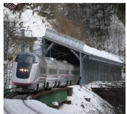
図-6 なだれ覆工
