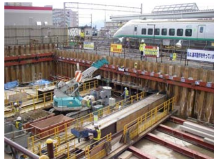
図－５ エレメントけん引状況
