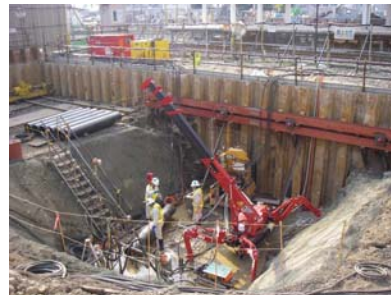
図－４ ハードロック施工状況
