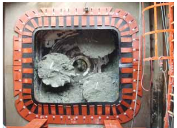
写真 - 4 矩形推進機到達状況
