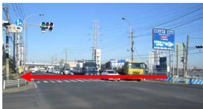
写真 - 1 工事箇所全景 (← : 推進ルート)
