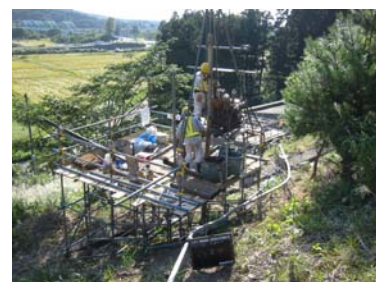
写真-1 充填孔の設置状況
