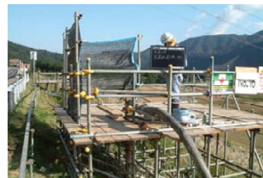
写真-2 充填状況
