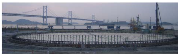
打設完了後 (2007/6/3 17:00 完了)
