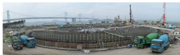
打設開始 5 時間経過 (中央部配管圧送) 2007/6/2 13:00
