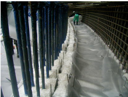
写真-3.1 養生材の敷設状況
