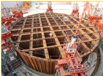
写真-2 鋼殻桁組立完了
