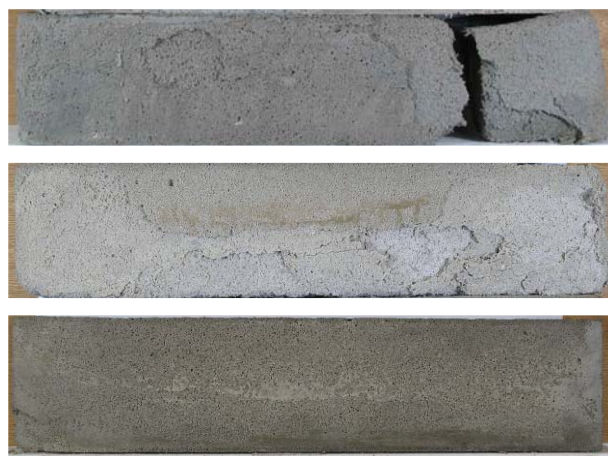
写真-1 各供試体の劣化状況（60 サイクル時点）
