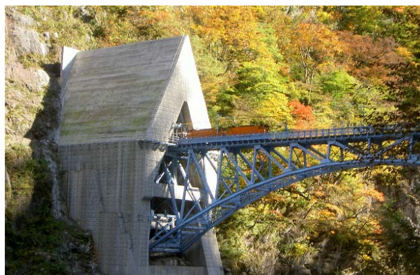
写真-2 ロックシェッド（竣工時）
