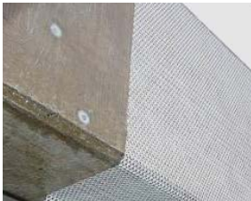
写真－3 貼付け状況
