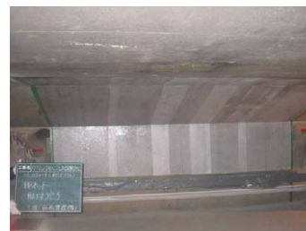
写真-5 施工完了状況
