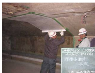
写真-4 シート貼付作業
