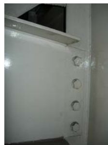
写真-3 横桁の主桁取付部のボルト
