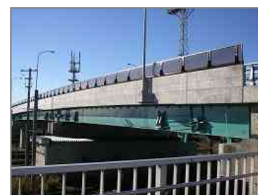
写真-5 扇田こ線橋(補強後)
