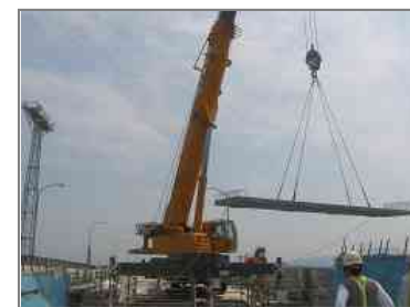
写真-3 床版架設状況
