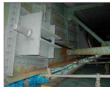
写真-4 外ケーブル工法
