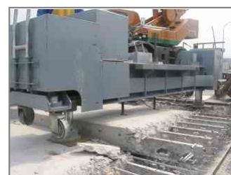
写真-2 ジャッキビーム工法
