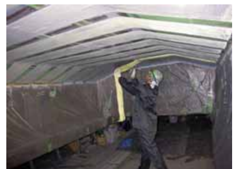
写真-5 シート貼り付け
