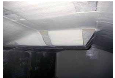
写真-4 形状変化部の補強
