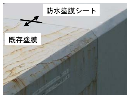
写真-5 試験施工箇所の調査状況
