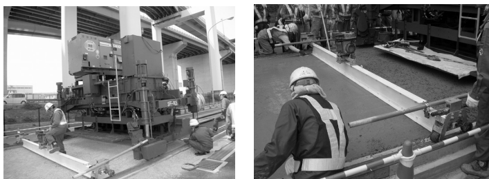
写真-1 試験施工に使用した締固め機械 (左：大型フィニシャー、右：簡易フィニシャー)
