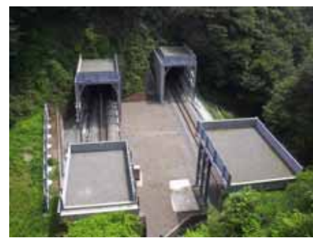
図-7 施工完了状況
