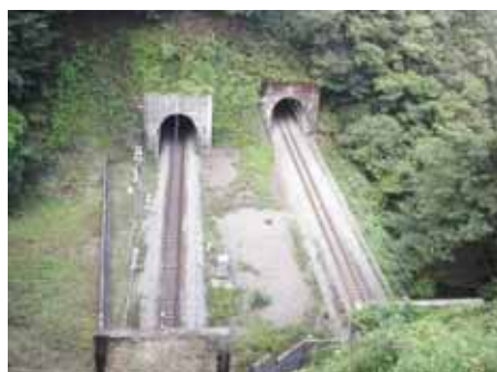
図-5 施工前状況
