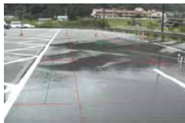
写真-1 散水状況写真
