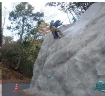
図 7 本材料の吹付
