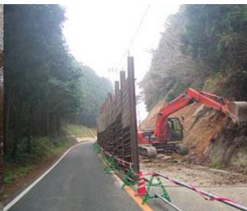
図 6 従来の再施工
