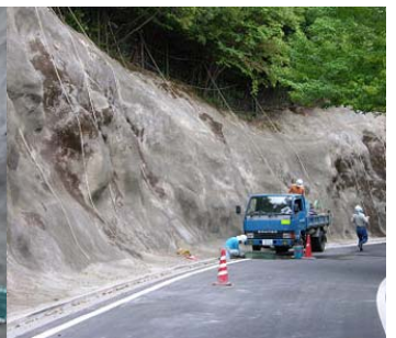
図 8 施工完了状況
