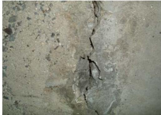
写真-2 目地部の浮き・剥離片の除去状況
