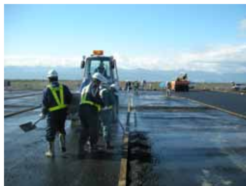
図 3 合材撒き出し作業
