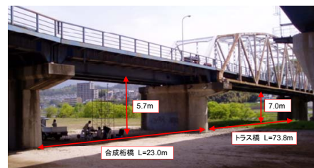
図7 合成桁橋およびトラス橋全景
