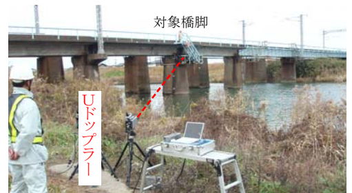
図3 在来線河川橋脚の現地測定状況
