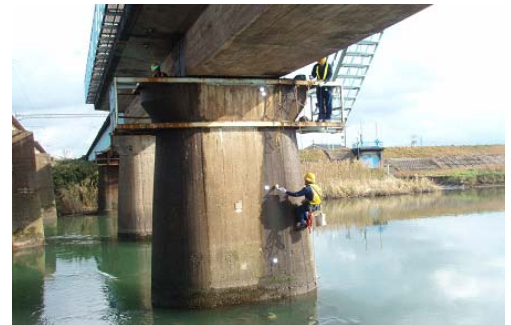
図2 橋脚へのセンサ類の取り付け作業
