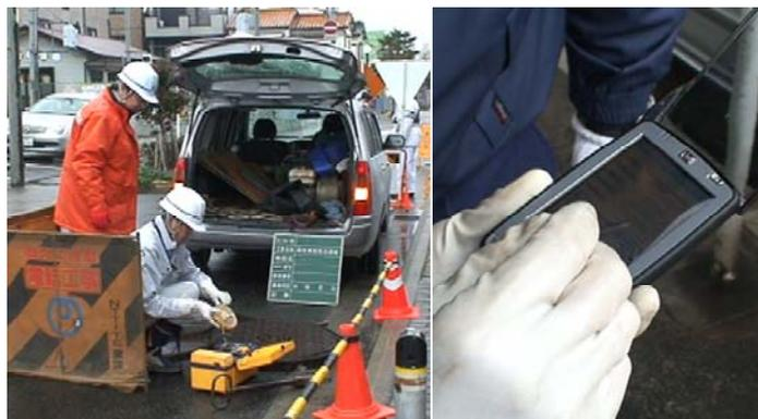
写真1 携帯端末による点検結果入力
