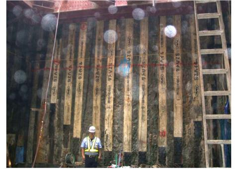
写真 - 4 6段目支保工撤去後全景
