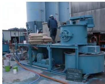
写真-2 裏込め注入プラント
